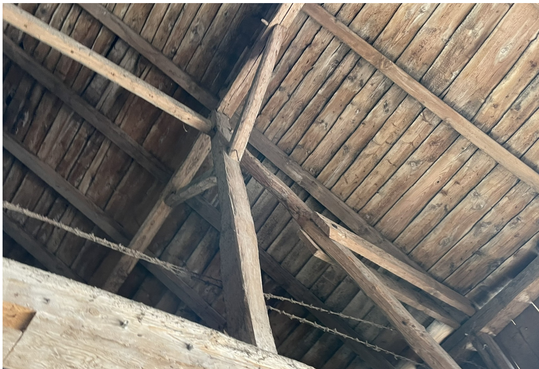
Fot.4 Konstrukcja dachu – wyboczenia w elementach
