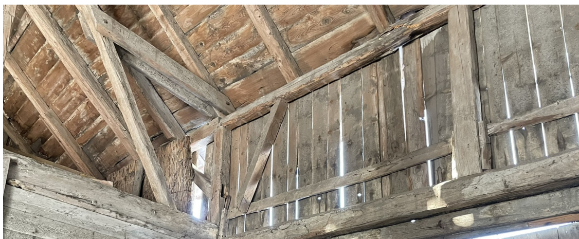
Fot.3 Konstrukcja dachu – pęknięcia w elementach
