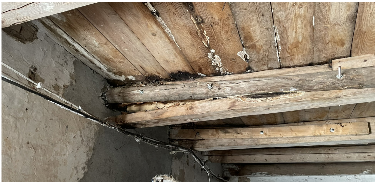
Fot.2 Widoczne uszkodzenia belek stropowych
