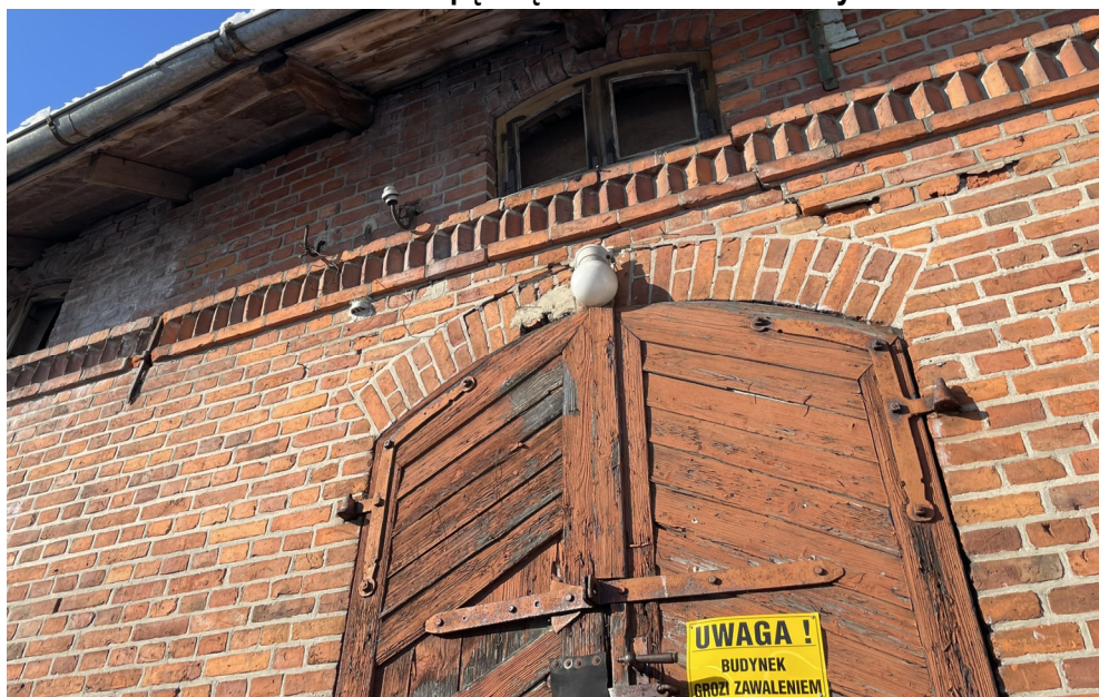
Fot.1 Widoczne pęknięcia na ścianach nośnych
